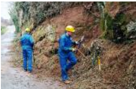
Clearing the Bromsgrove SSSI.
